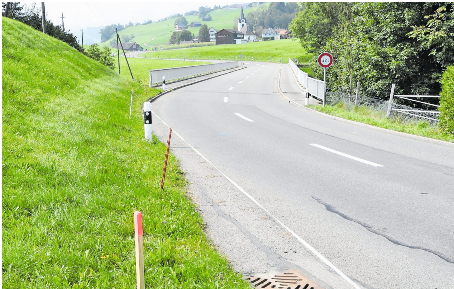
Die Markierungen zeigen, wo die Strasse zur Luterer-Brücke neu durchgehen wird. Die heutige Brücke wird abgerissen. Bild: Sabine Camedda
